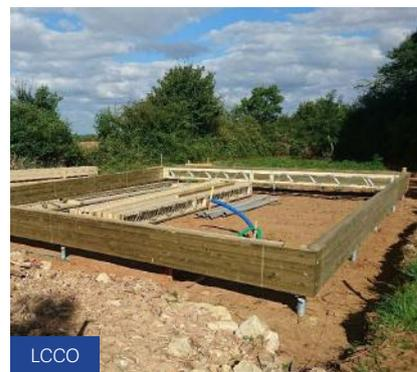
Plancher rez-de-chaussée sur pieux
