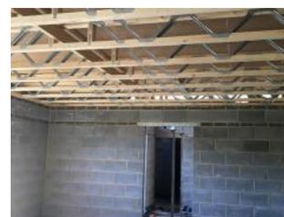
**Poutre POSI® encastrée - appui sur membrure basse**
