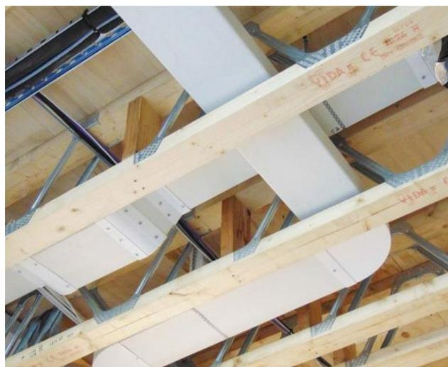
Son avantage majeur est la grande facilité d'installation pour toutes les gaines de ventilation, canalisations ou évacuation. Aucun perçage, aucune zone d'affaiblissement, elle permet un travail propre et rapide, bien plus simple qu'avec des poutres en I ou massives.
