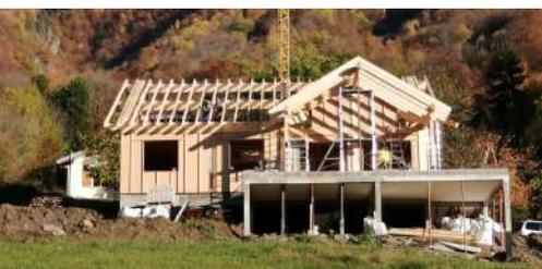
**Charpentes traditionnelles** : structures pré-taillées en usine, elles sont prêtes à être posées. La mise en œuvre est donc rapide, tout est redimensionné et les combles sont aménageables !
