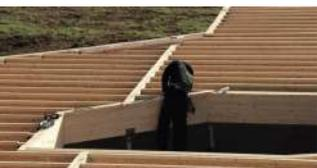
C'est une offre en composants prétaillés pour une alternative aux dalles béton. La pose se fait sur plots béton ou pieux vissés, avec une ceinture porteuse et sommiers en lamibois ou lamellé-collé pré-taillé.
