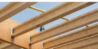
**Planchers poutre en I :** c'est une structure primaire pré-taillée, composée de poutres porteuses, de sommiers, de poteaux et de trémie d'escaliers suivi d'un plancher léger pré-taillé dimensionné à chaque projet. La manutention est aisée et rapide, il est facile de percer les poutres pour faire passer les réseaux techniques. Avec cette solution, les problèmes de grincements sont éliminés.
