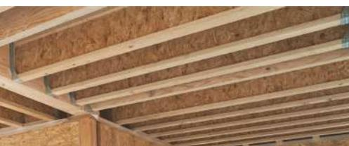
**Toit plat** : structure avec poutres en I prétaillées. La pente se fait soit avec des cales de pente ou directement avec les poutres en I inclinées. L'isolant sera insufflé entre les poutres en I.
