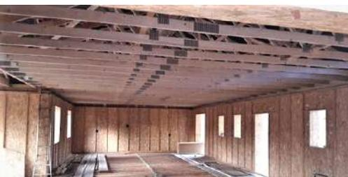
**Charpentes à fermettes** : ayant un bon rapport qualité prix, ce type de charpente prétaillée est rapide à mettre en œuvre.
