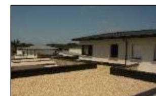
Positionnement du gravier pour lestage final
