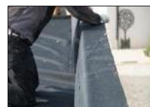
Collage et marouflage de la membrane sur le support
