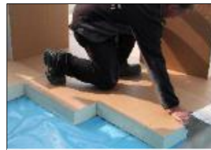
Pose de l'isolant
