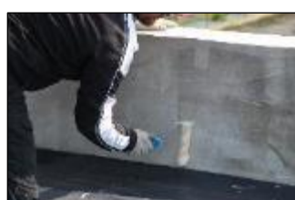
Encollage des relevés d'étanchéité
