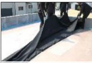
Dépliage de la membrane
