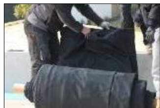
Déroulement de la membrane
