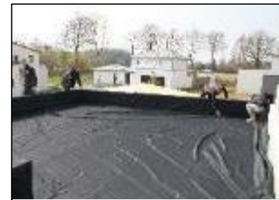
Positionnement et ajustement de la membrane
